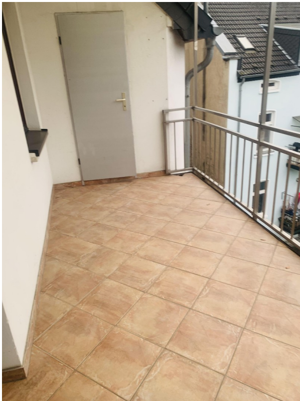
Terrasse mit Speicher
