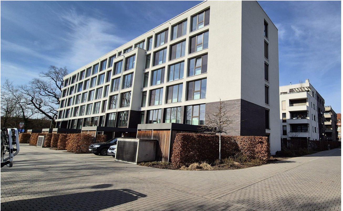
Gebäude von außen
