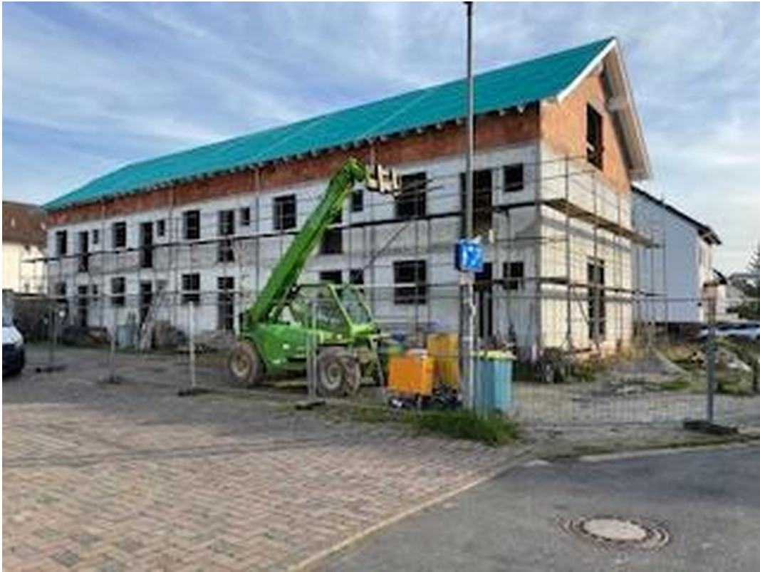
Straßenansicht Objekt Gründau
