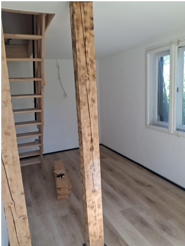
Ferienhaus Treppe zum OG
