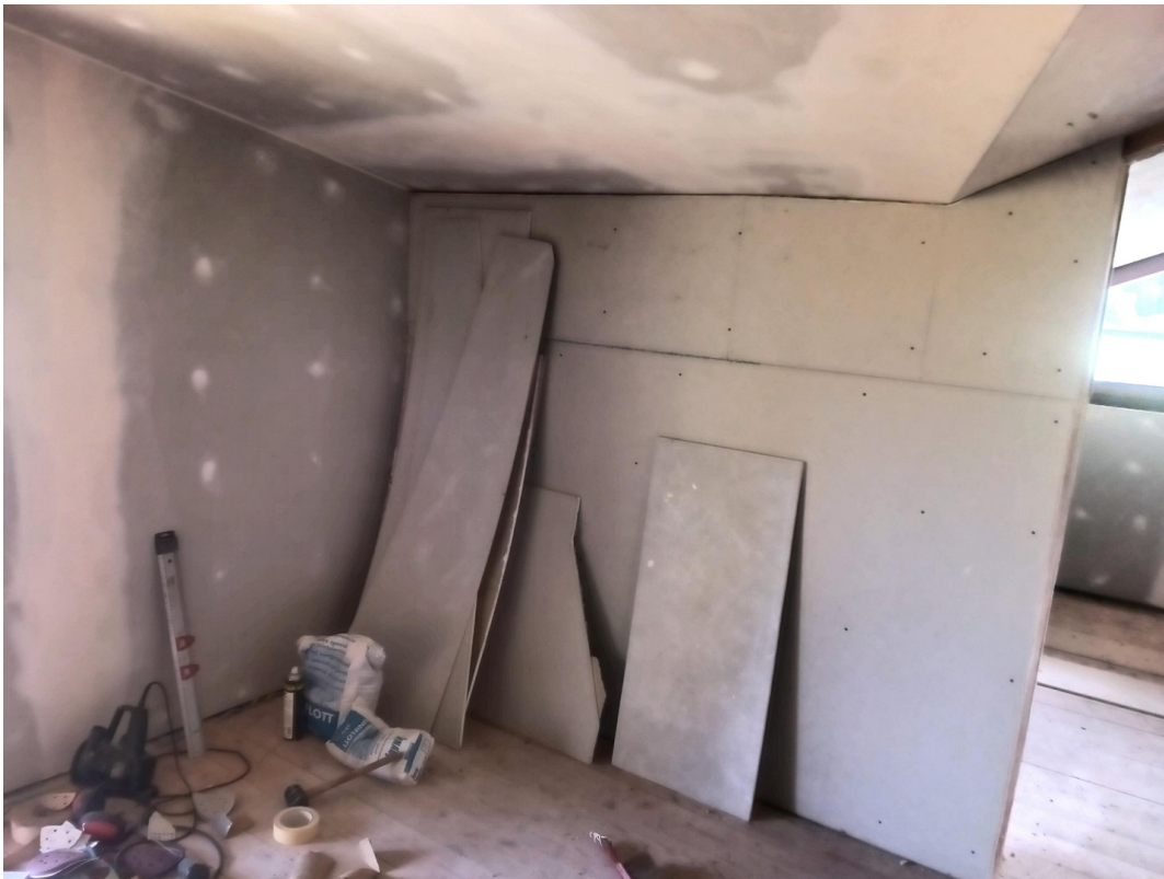
Holzhaus OG Eingang
