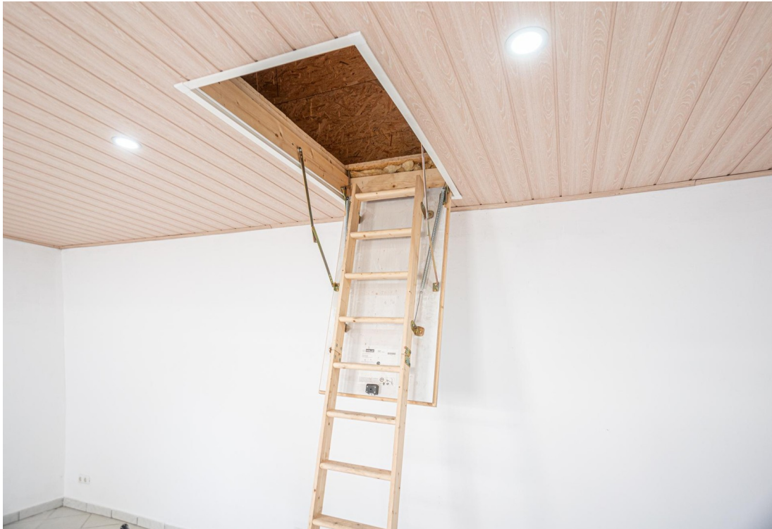
Zugang zur Nutzfläche
