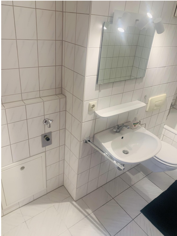
Waschmaschinen Anschluss
