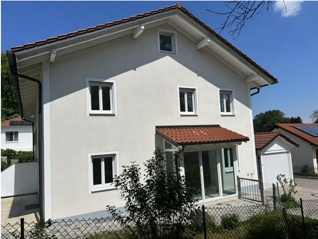
Südseite mit Wintergarten
