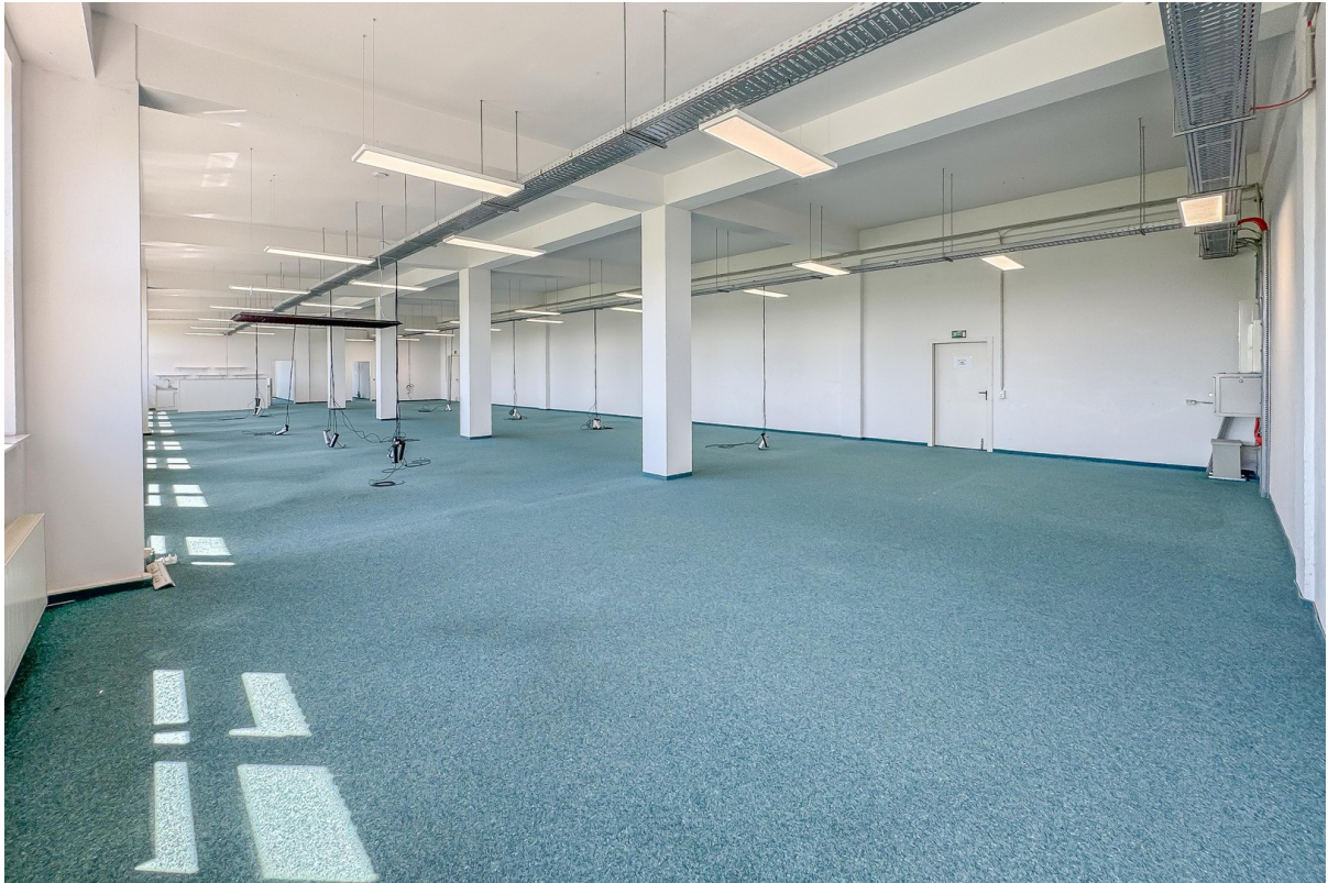
Lagerfläche (Beton u. Teppich)
