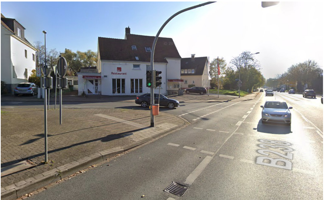
Ansicht, Fahrtrichtung Detmold
