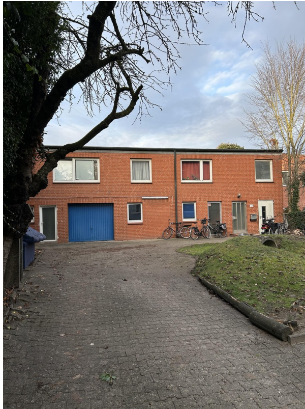
Vorderansicht Gebäude B
