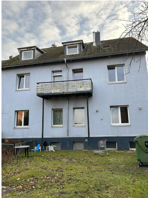
Rückansicht Hauptgebäude A
