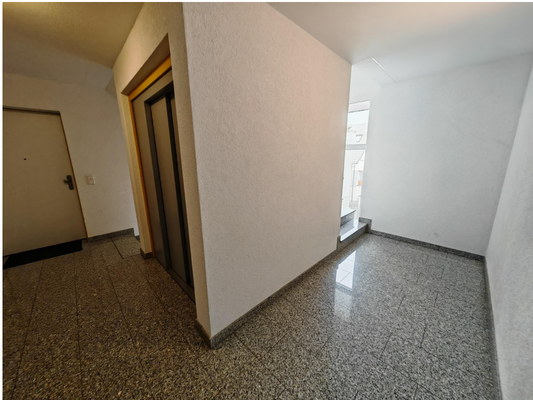
Treppenhaus mit Fahrstuhl
