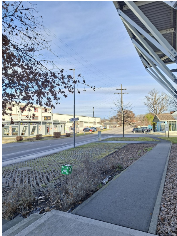
Übersicht über das Gebäude_3
