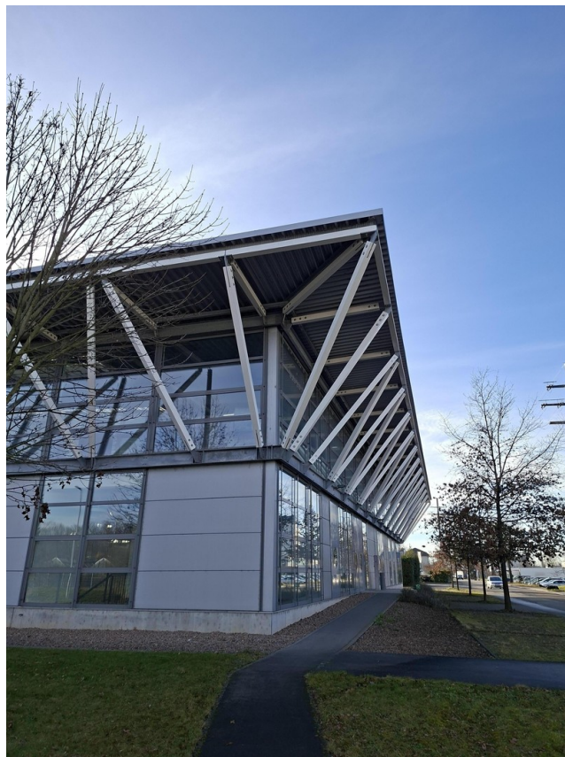
Übersicht über das Gebäude_1
