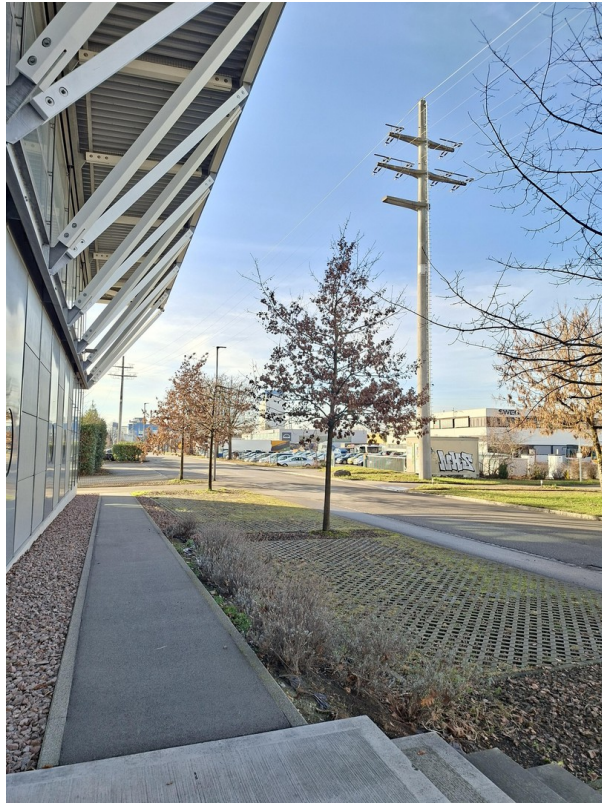
Übersicht über das Gebäude_2
