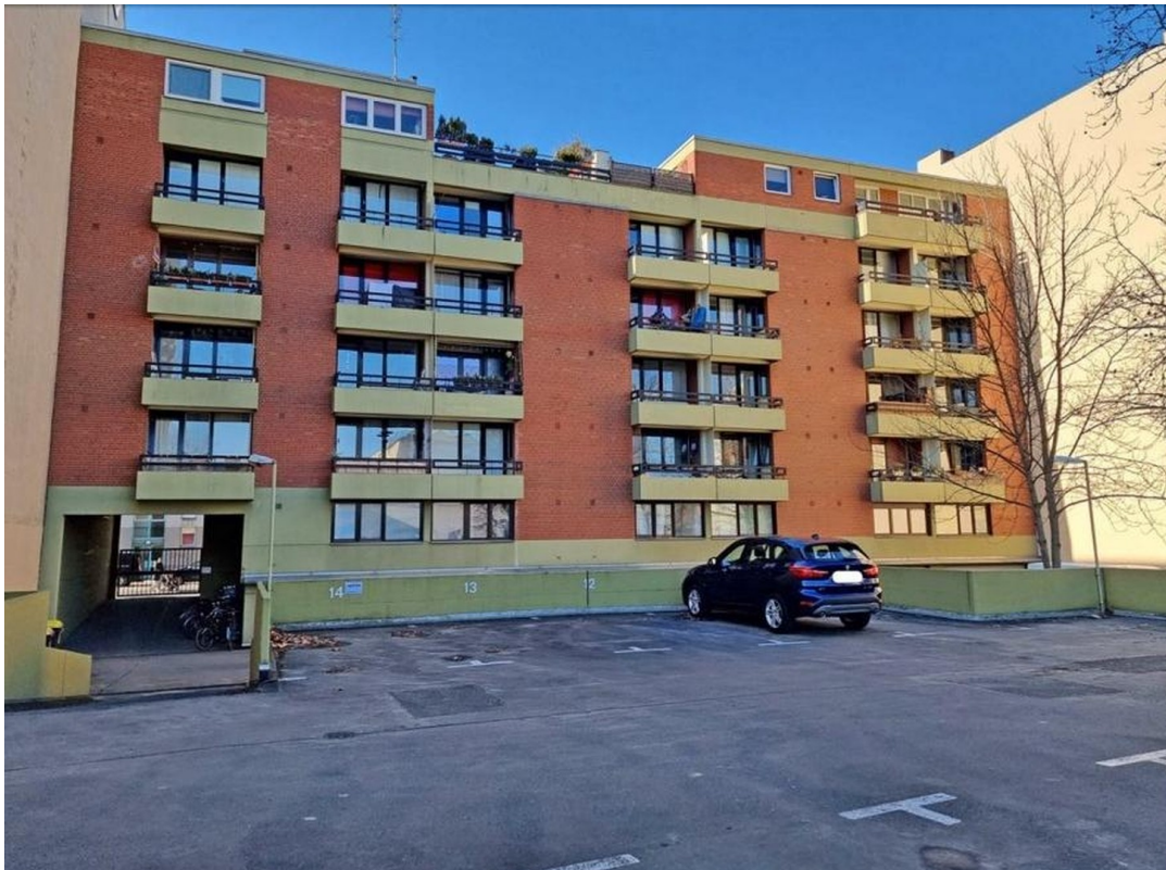
Parkdeck und Rückansicht Haus
