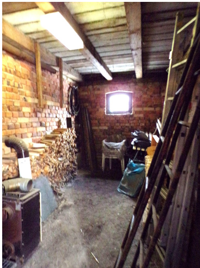
Nebengebäude Ansicht IV
