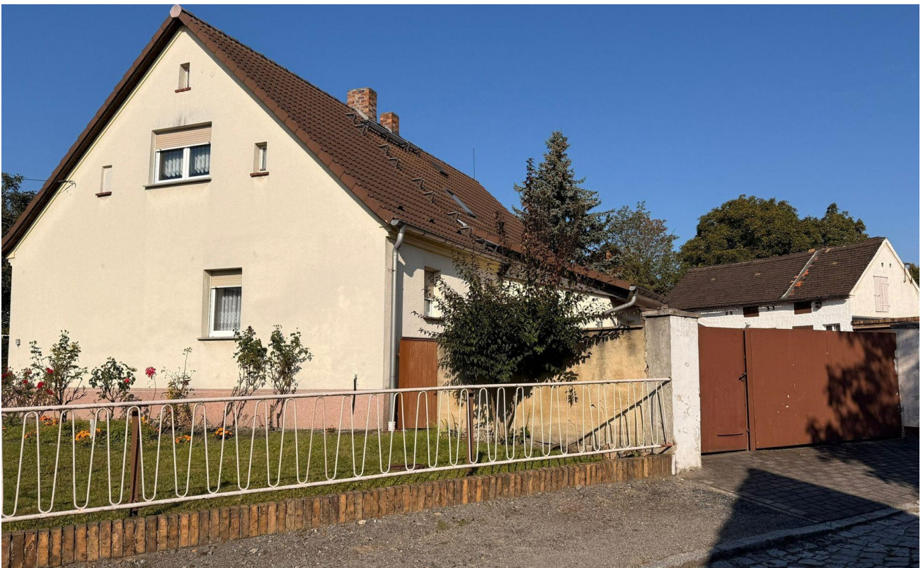
Haus Straßenseite IV
