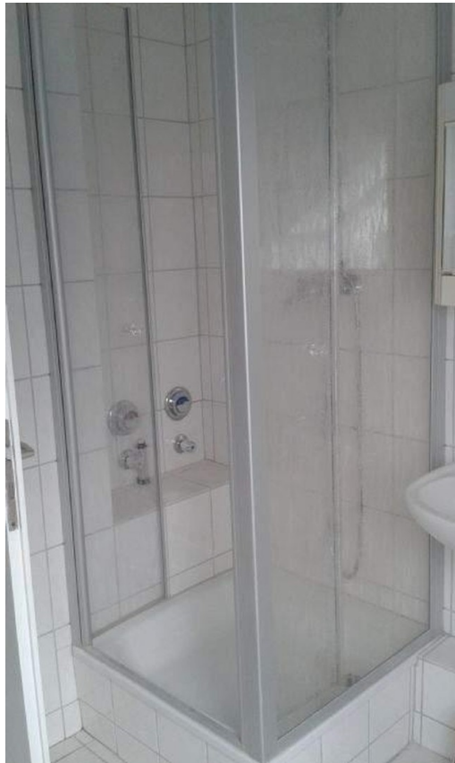
Bad mit Dusche
