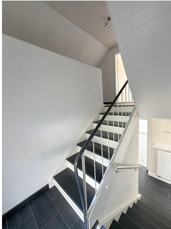
Treppenhaus EG - OG
