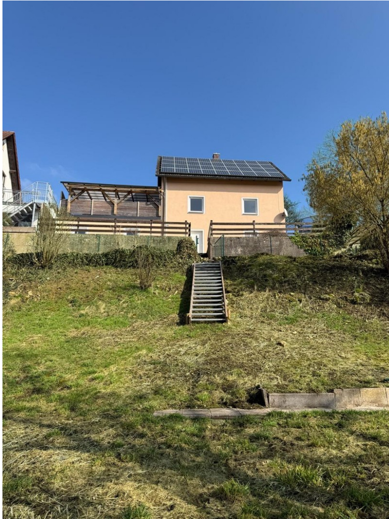
Blick auf Haus mit Solaranlage
