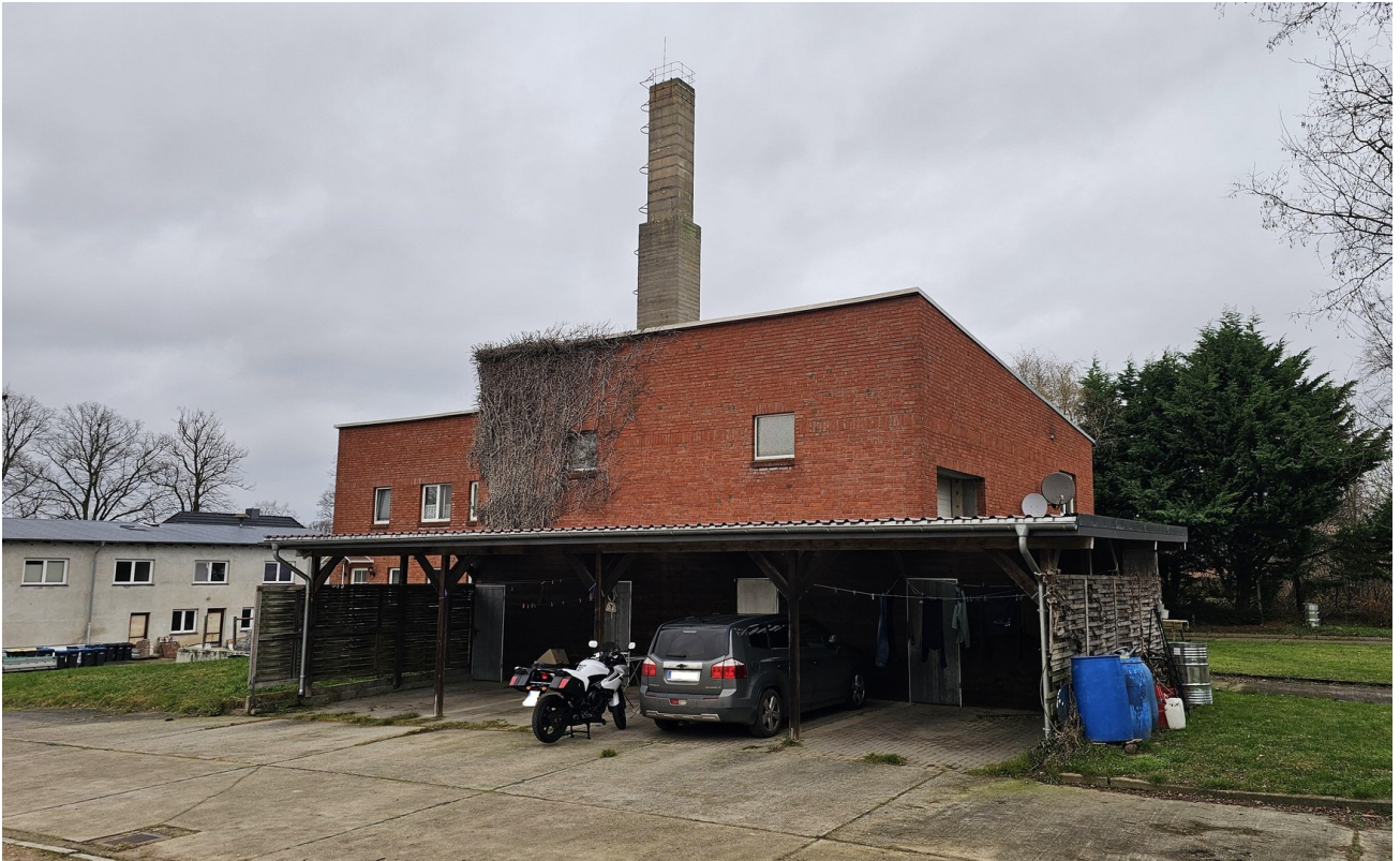
Carport mit Abstellraum
