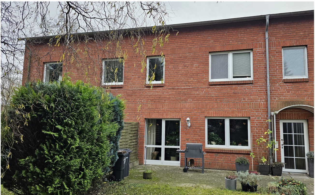
Wohnungseingang mit Terrasse
