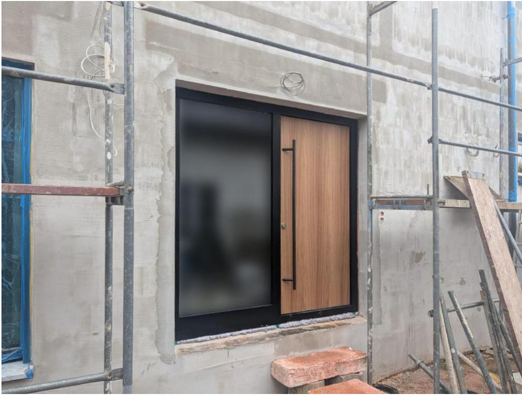
Eingangstür HWE - Außen
