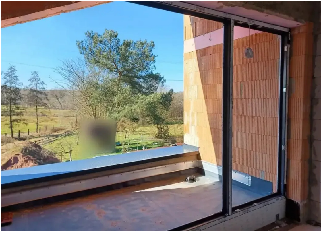
OG - Blick von der Loggia
