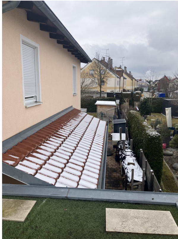
Überdachung Kellerabgang
