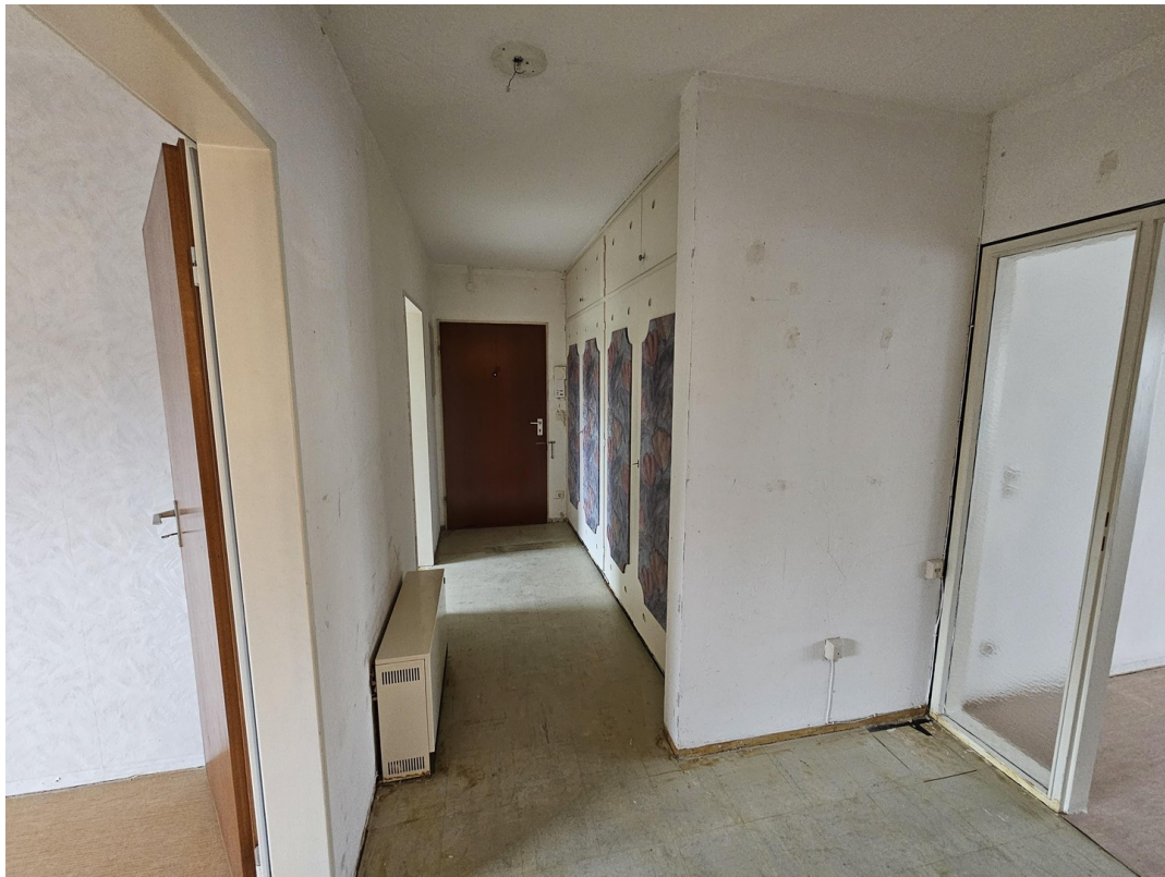
Blick vom Bad in den Flur
