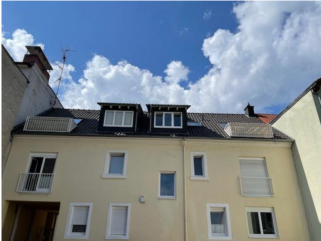
Hausrückseite mit eigenem Hof
