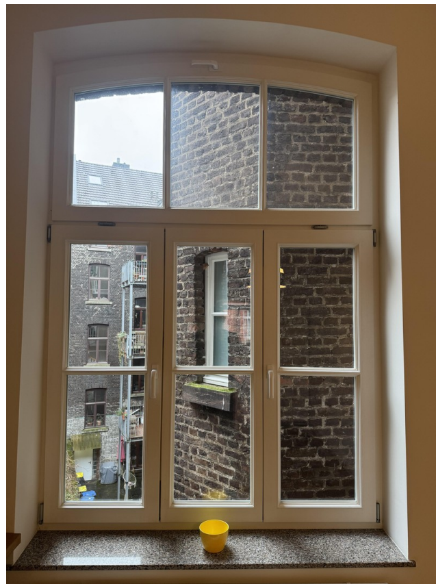
Blick Küche in den Hof
