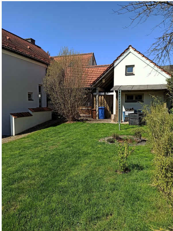
Westansicht Rückseite Garage
