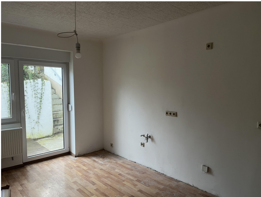
Küche, verputzt und gestrichen
