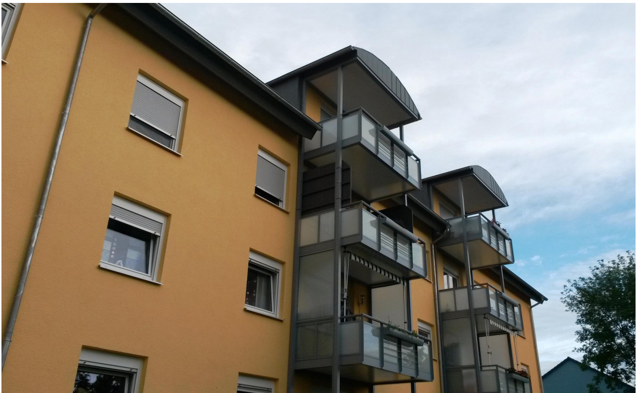
Balkon oben links überdacht
