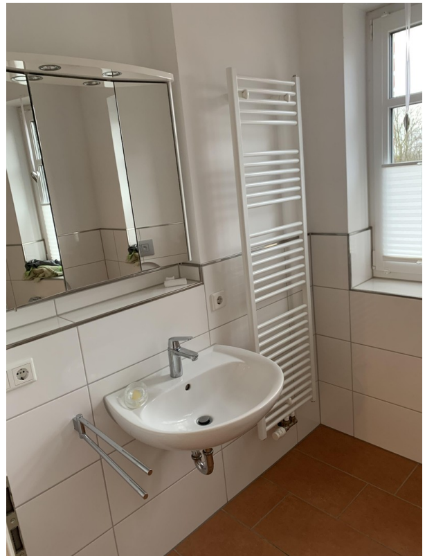
Bad mit Handtuchheizkörper
