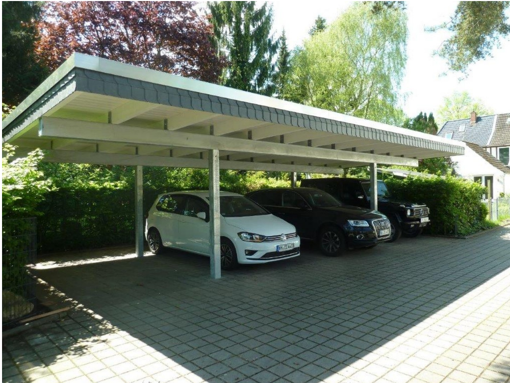
Carport mit 4 Stellplätzen
