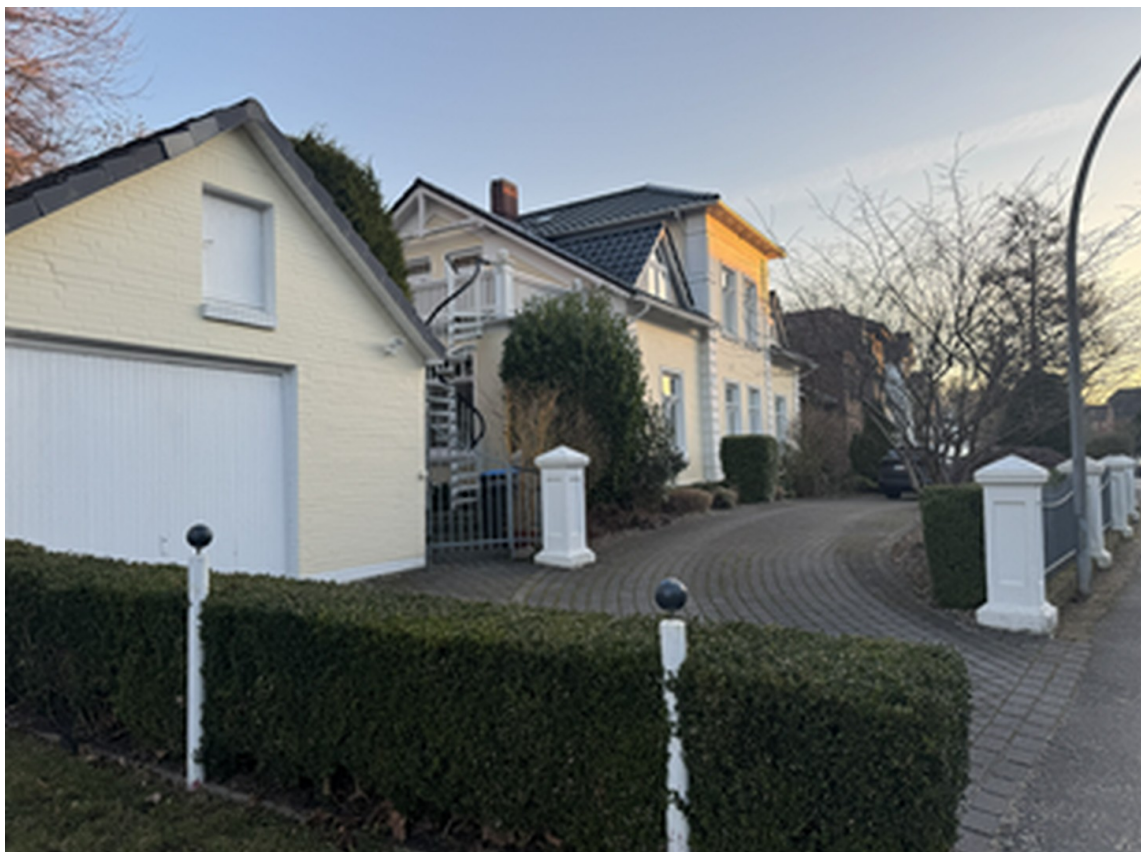
Villa | Garage u. Vorfahrt
