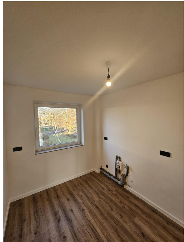
Küche mit neuen Anschlüssen
