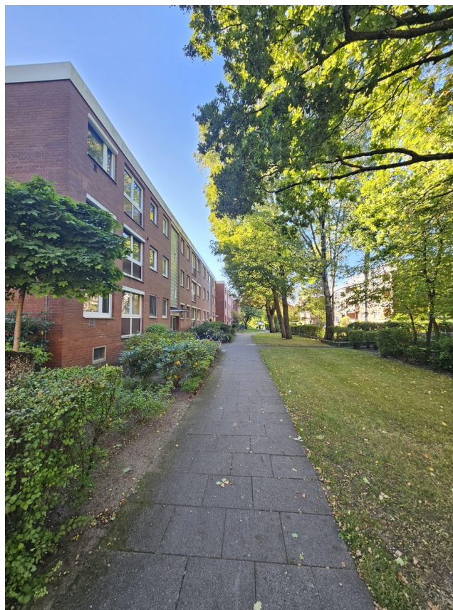
Blick zum Eingangsbereich
