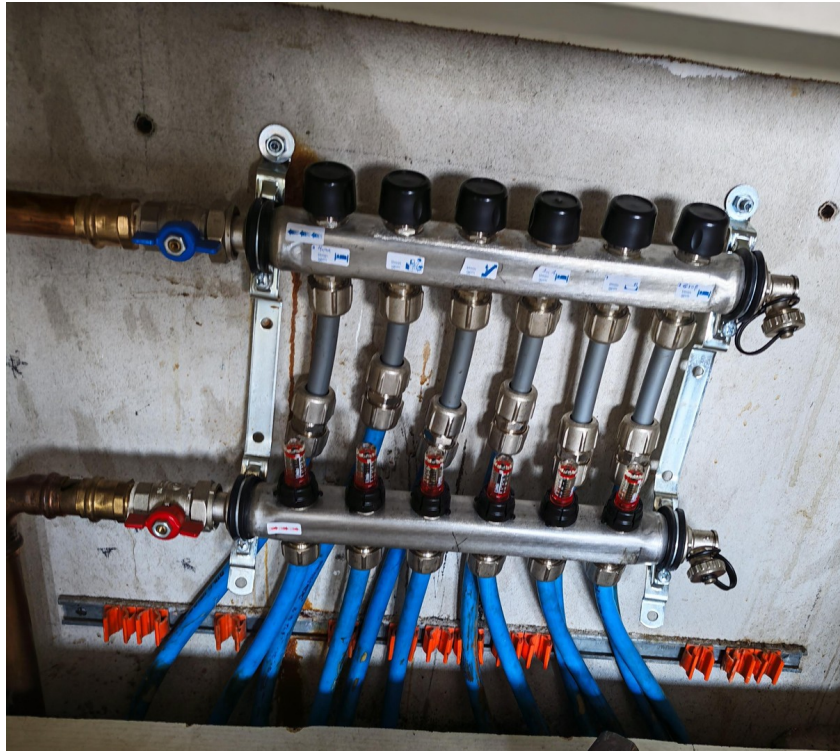
Fußbodenheizung OG
