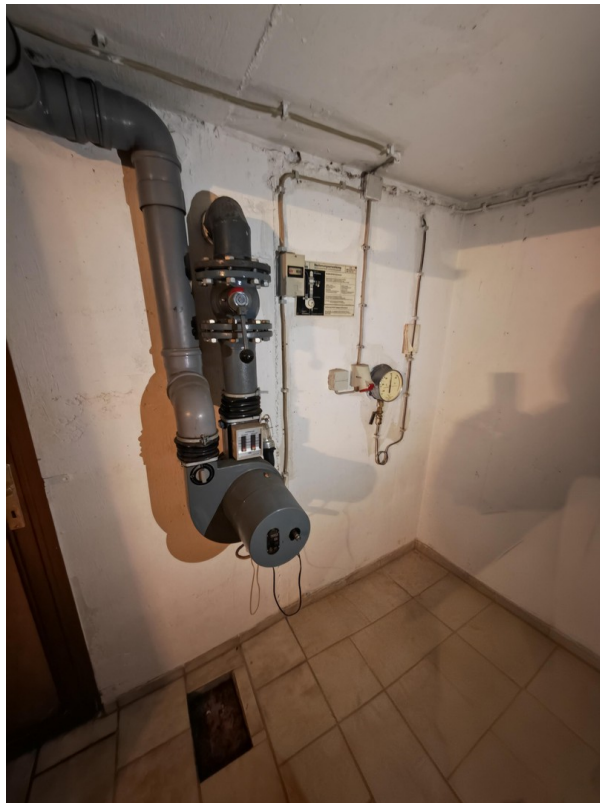
Luftfilteranlage (Bunker)
