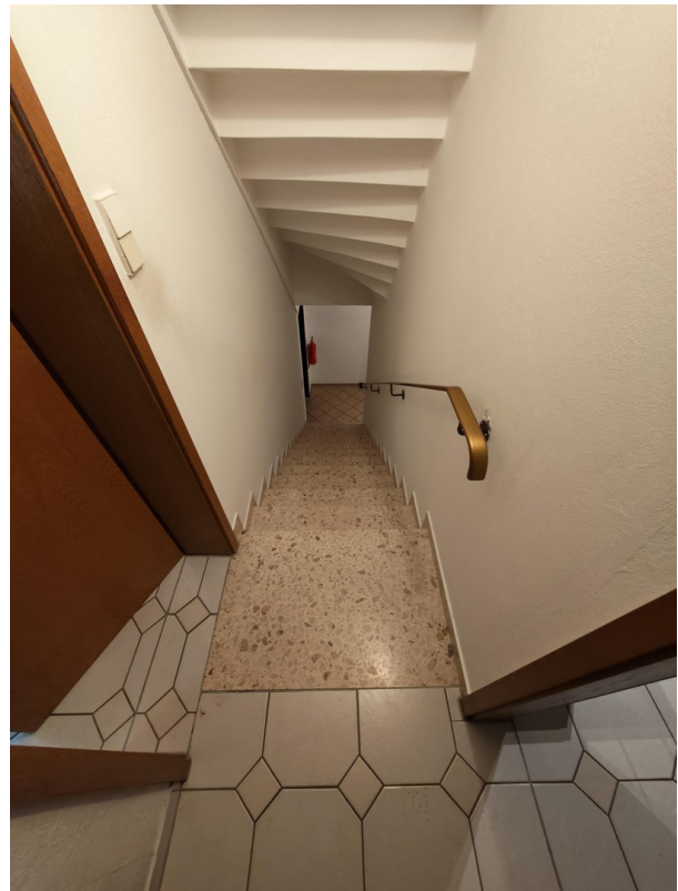
Kellerzugang ü.beide Einheiten
