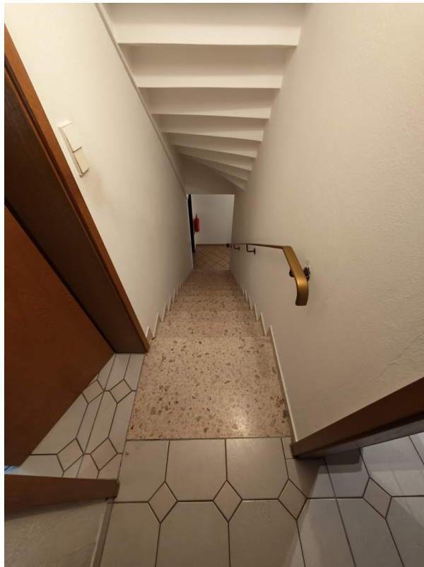
Kellerzugang ü.beide Einheiten
