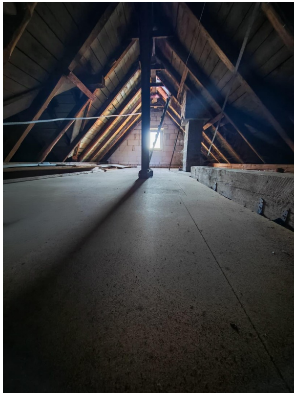
Dach (Geschossdecke gedämmt)
