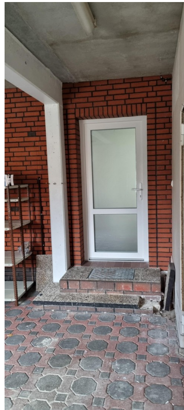
Eingang EG dir. von der Garage
