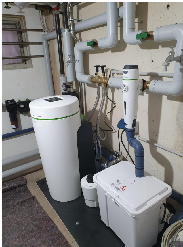
Entkalkungsanlage
