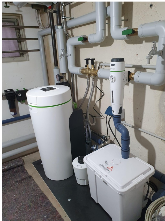
Entkalkungsanlage
