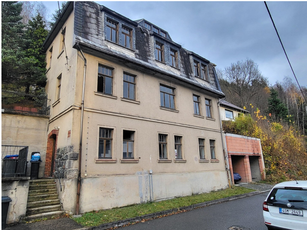
entkerntes Haus mit Garagen
