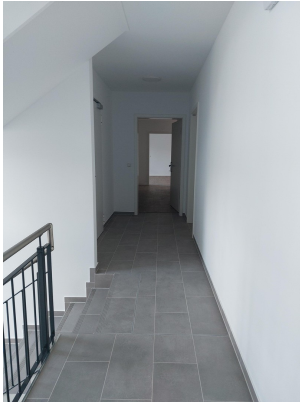
Hausflur vor der Wohnung
