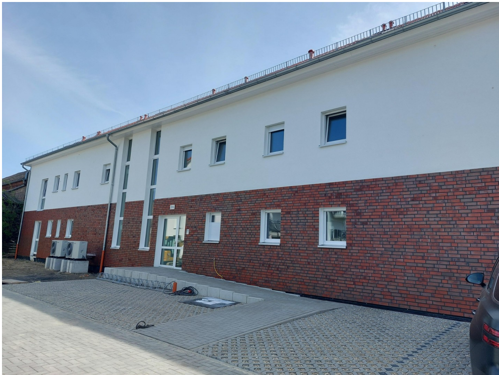
Eingangsbereich Haus C
