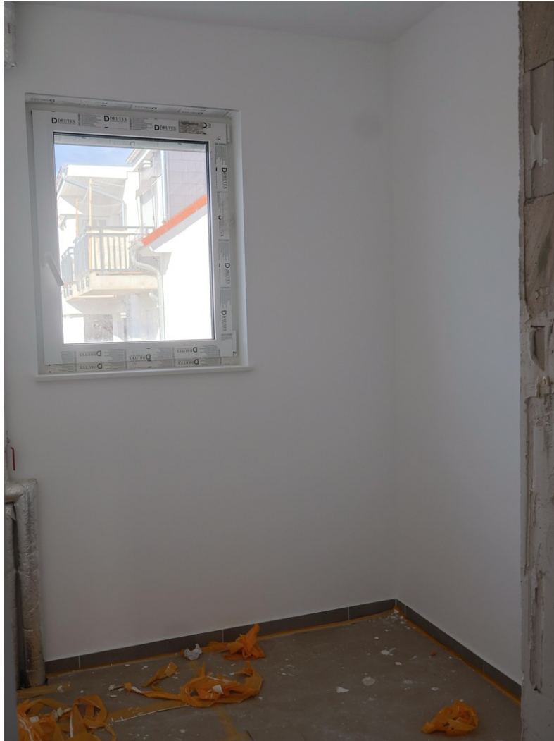
Büro/Abstellbereich im Bau
