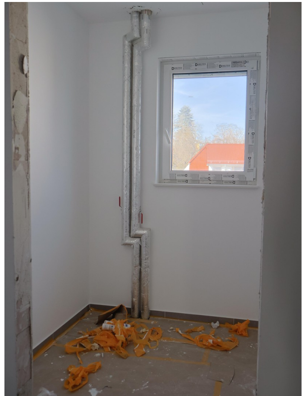
Büro/Abstellbereich im Bau
