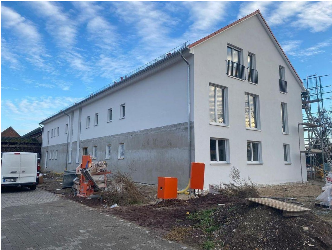
Haus C Straßenansicht im Bau
