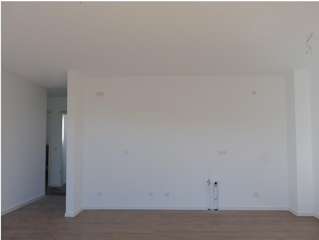
Küchenzeile wird noch gebaut
