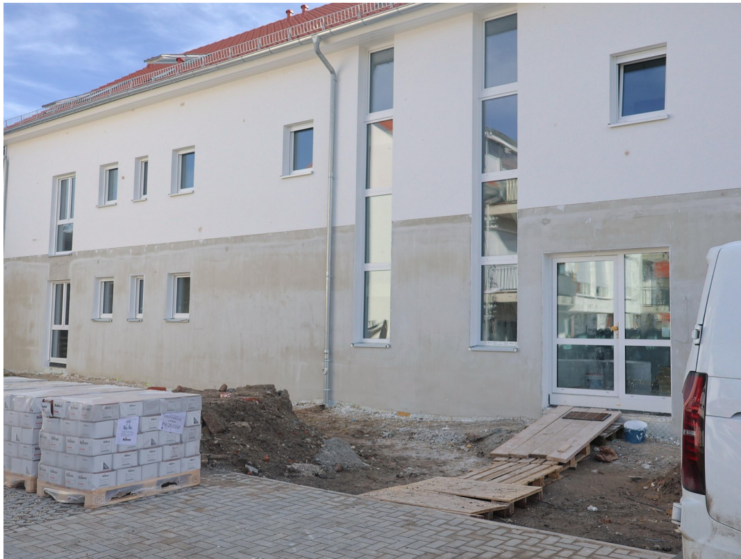
Eingangsbereich im Bau
