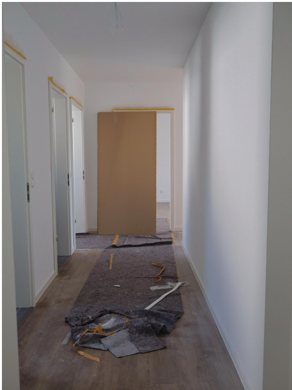
Flur/ Eingangsbereich im Bau
