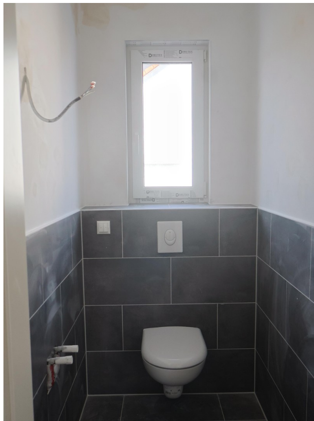
Gäste WC im Bau
