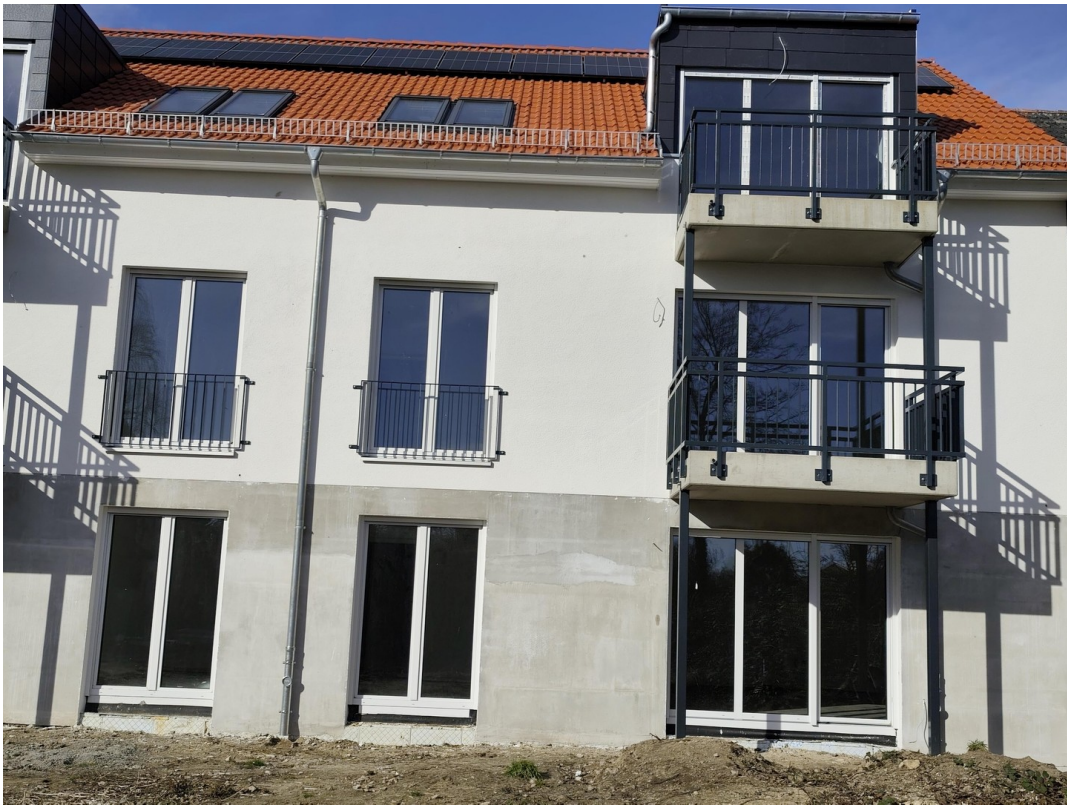
Balkon 1. OG in Südlage
