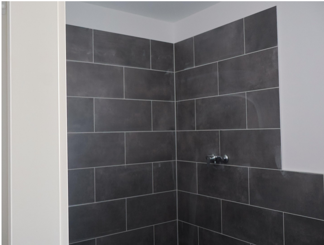
Bad Duschbereich im Bau
