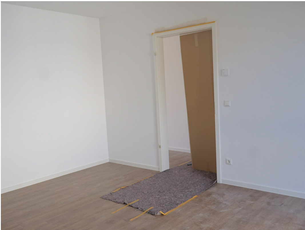
Schlafzimmer zum Flur im Bau
