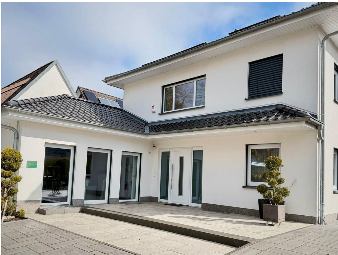
Blick von außen
