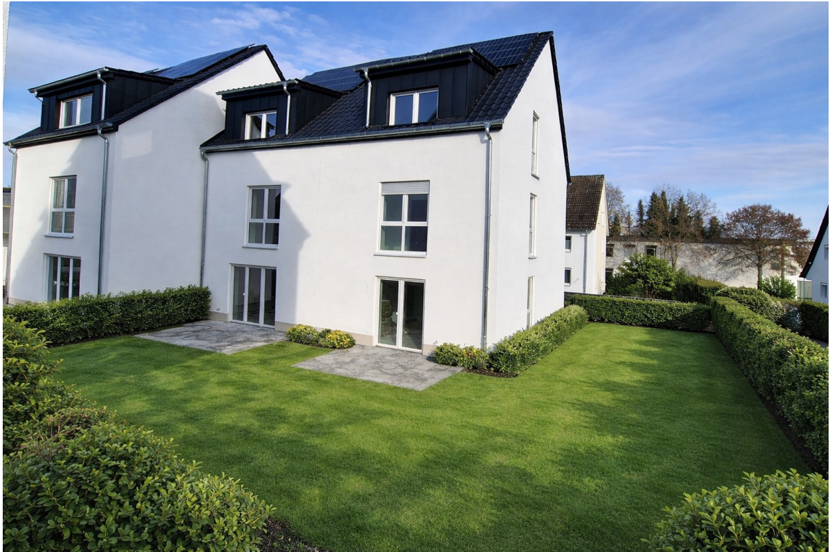
Terrassenbereich der Häuser
