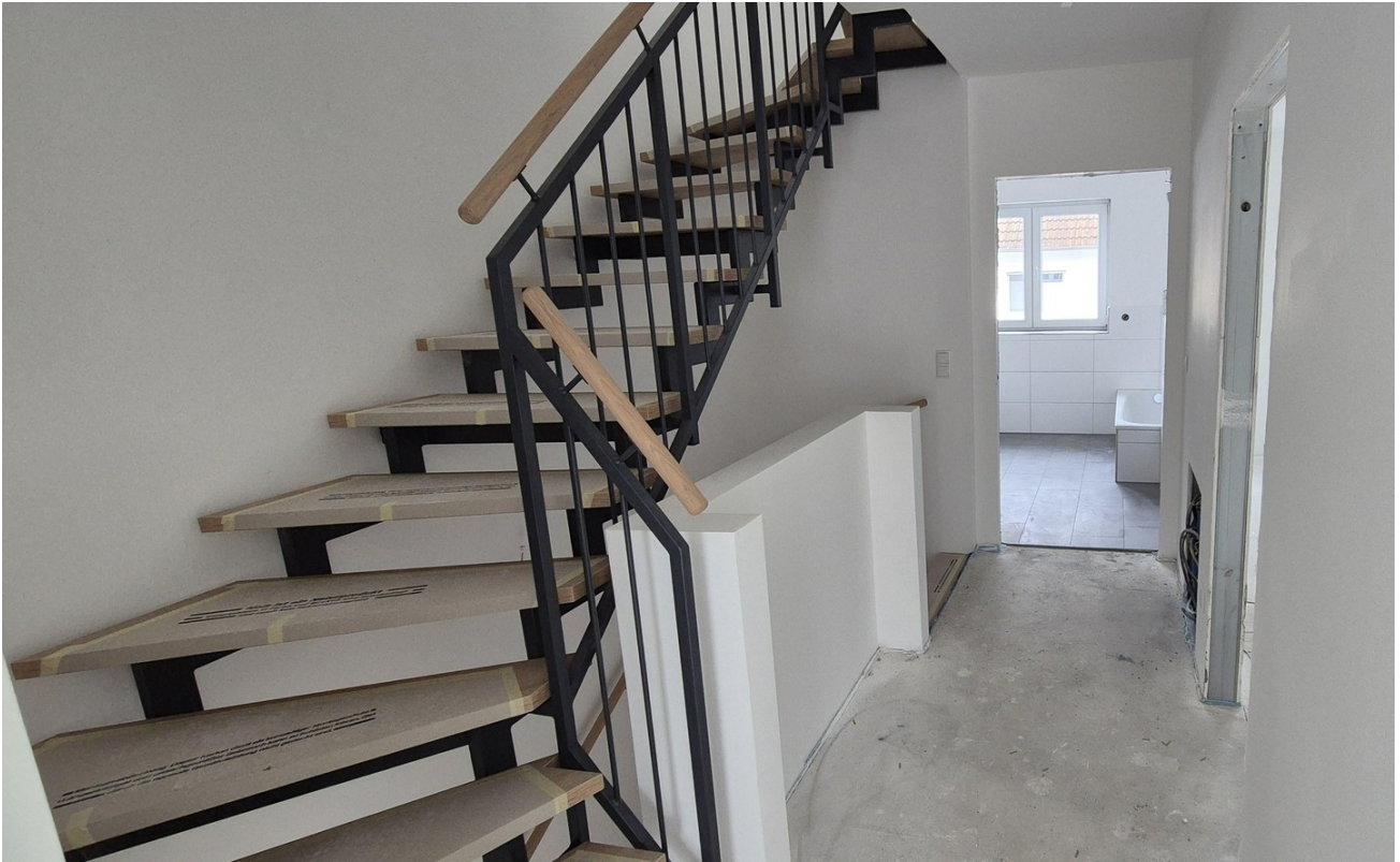
Treppe Flur OG
