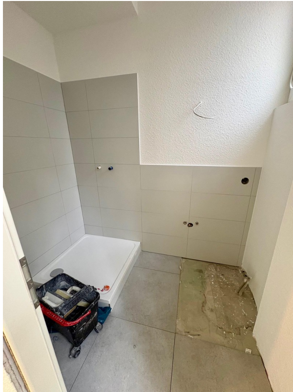
Duschbad im Ausbau
