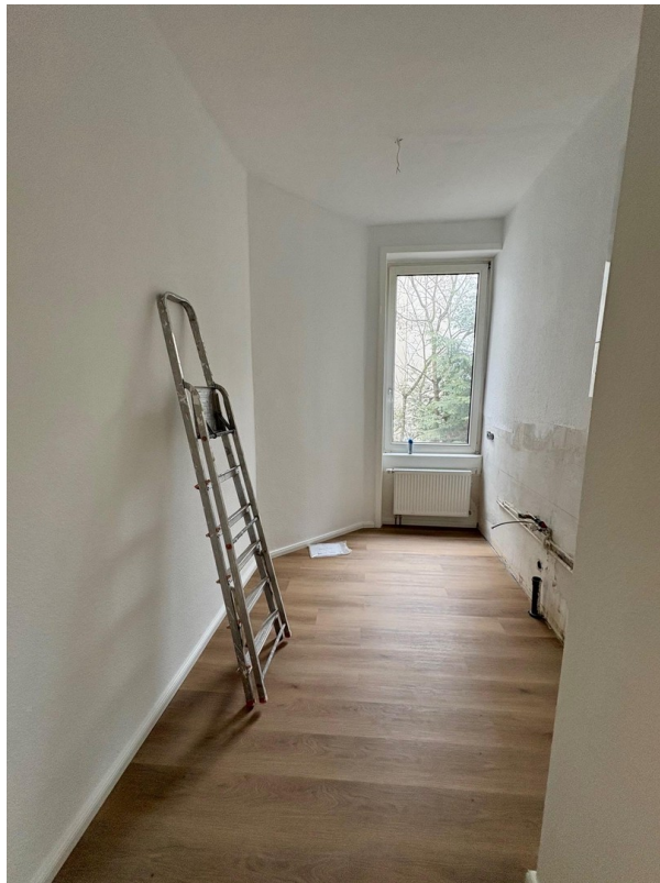
Küche in Ausbau
