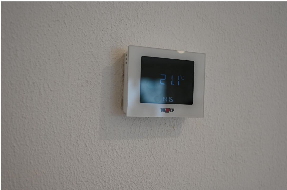
digitale Heizungssteuerung
