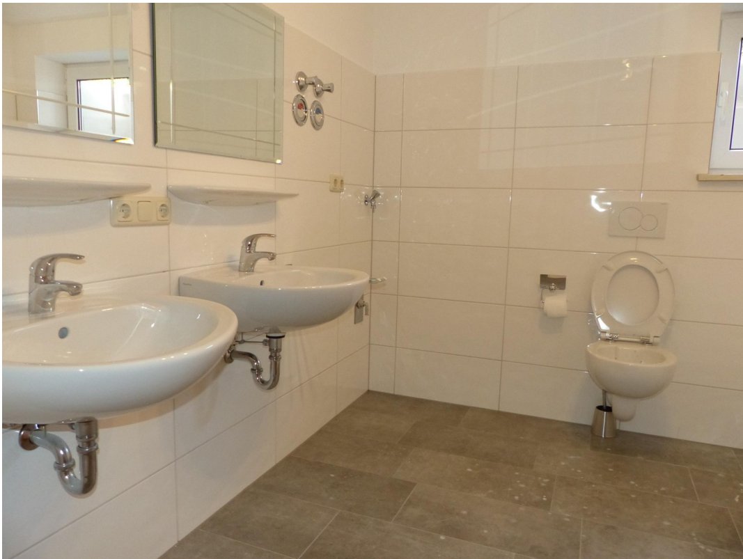
Bad mit Fußbodenheizung
