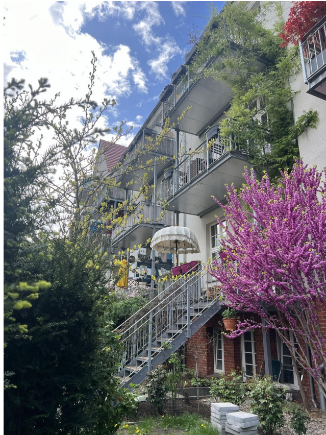
Blick auf Balkon 1
