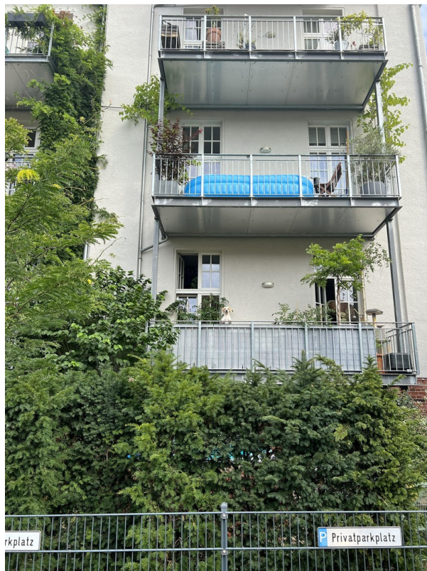
Blick auf Balkon 2
