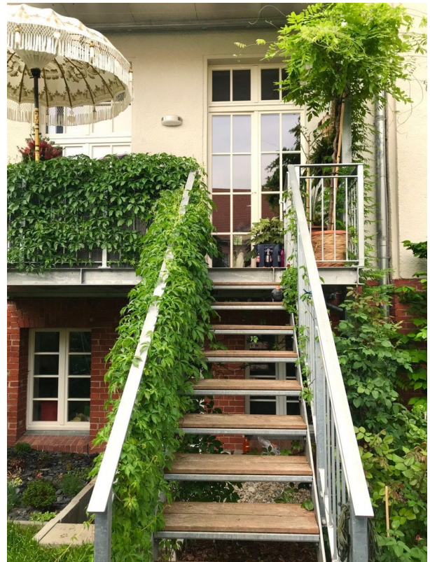
Aufgang Balkon 1 + Souterrain
