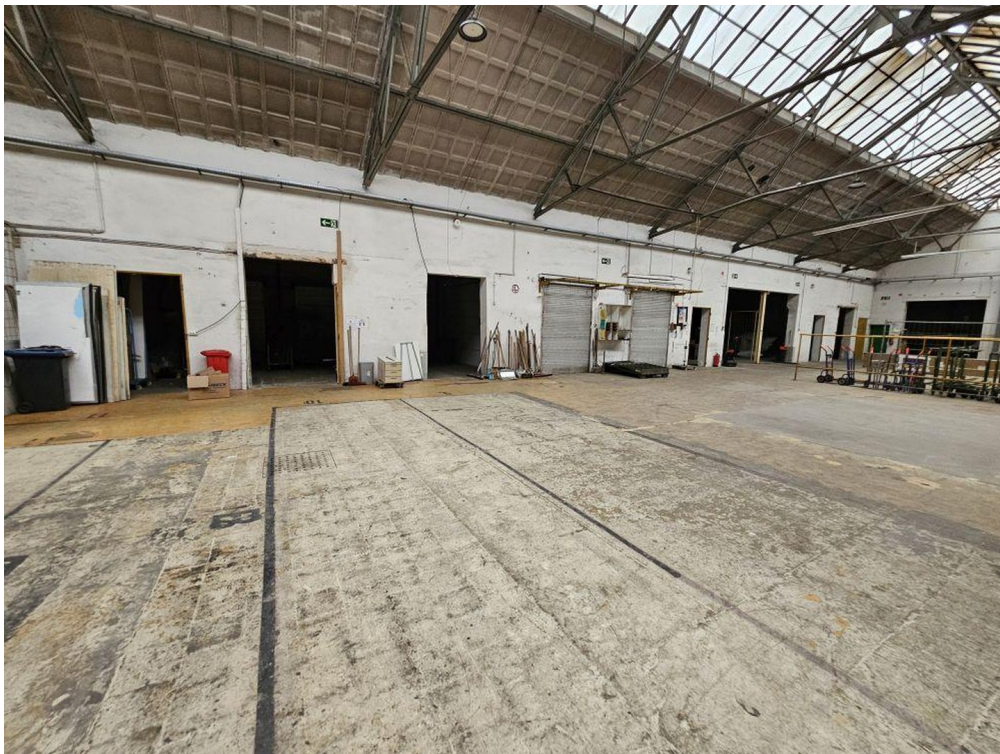
Zugang zu einigen Ladetoren
