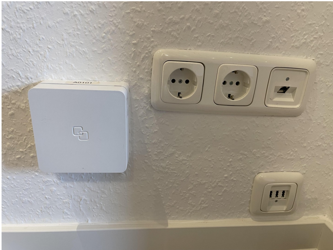
Glasfaser- /Telefonanschluss
