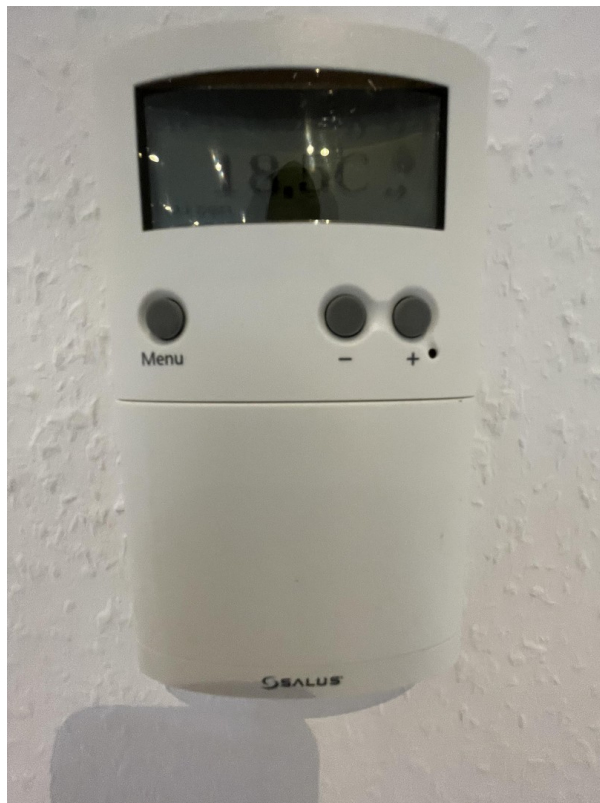
Heizungssteuerung
