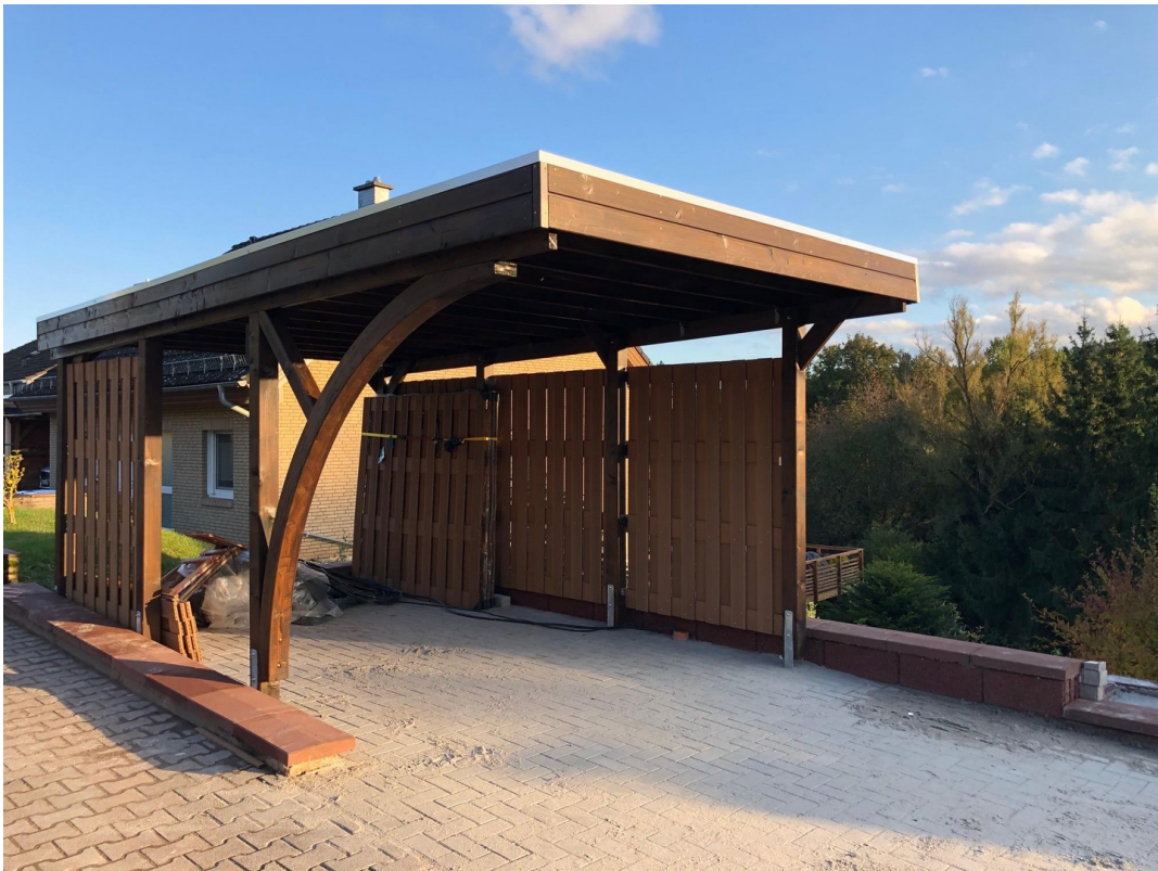
Carport mit Wall-Box
