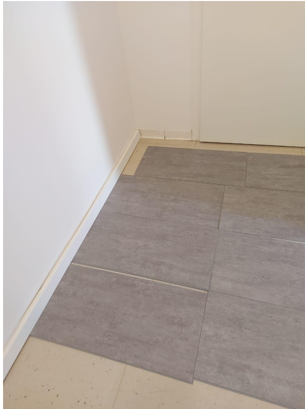
Boden Flur (in Arbeit)
