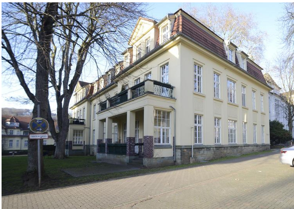
Aussenansicht Eckwohnung EG
