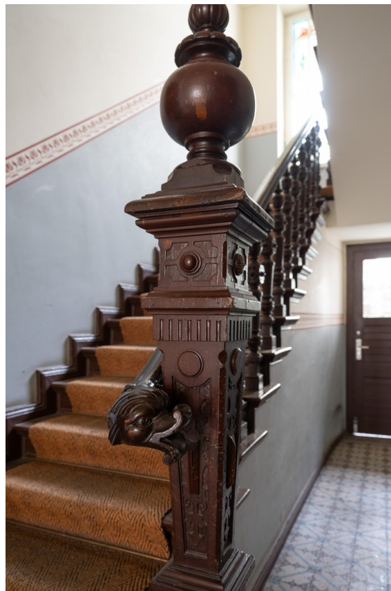
Treppengeländer am Eingang
