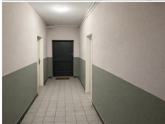
Flur + WC Eingang Rückseite
