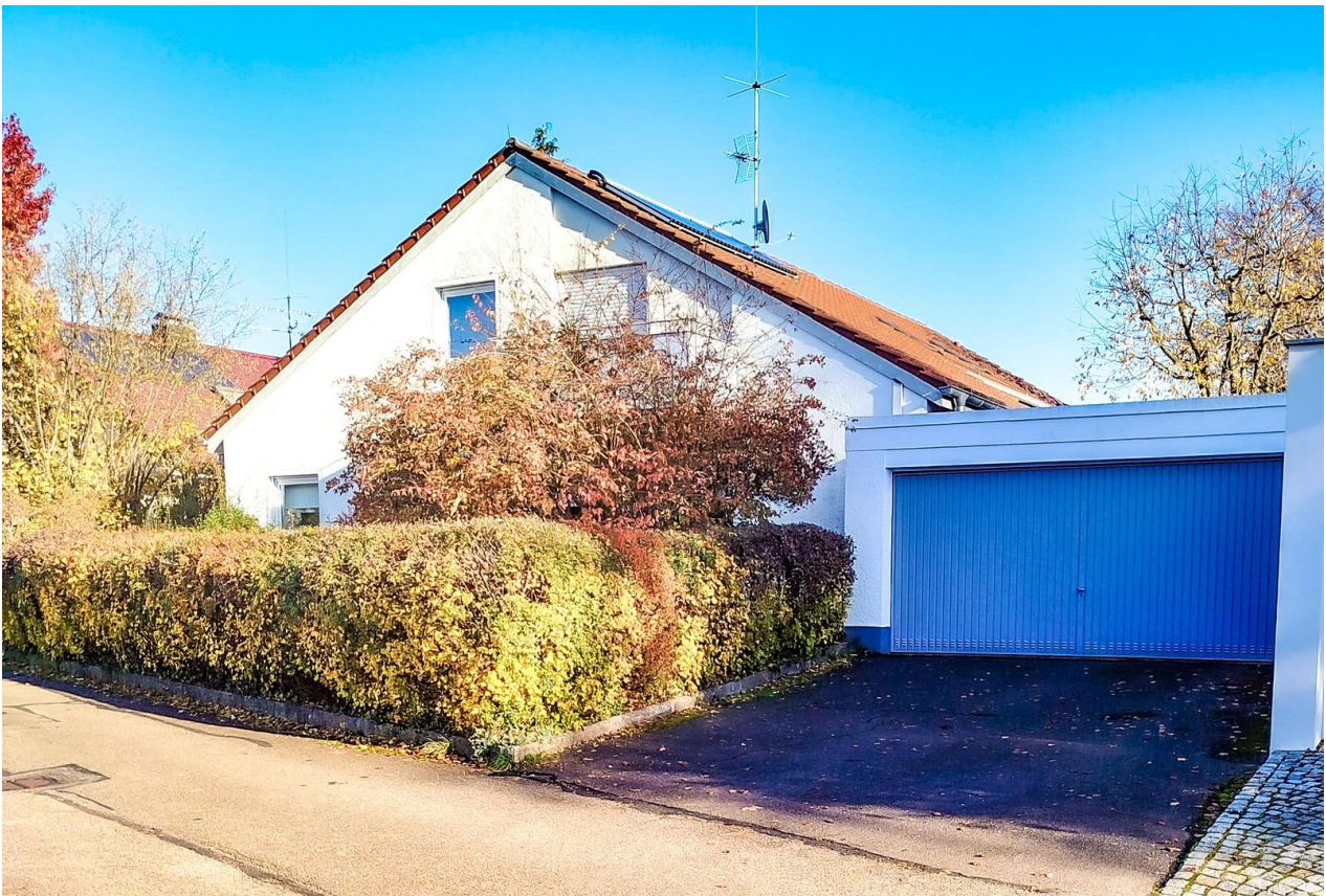
Doppelgarage mit Stellplätzen
